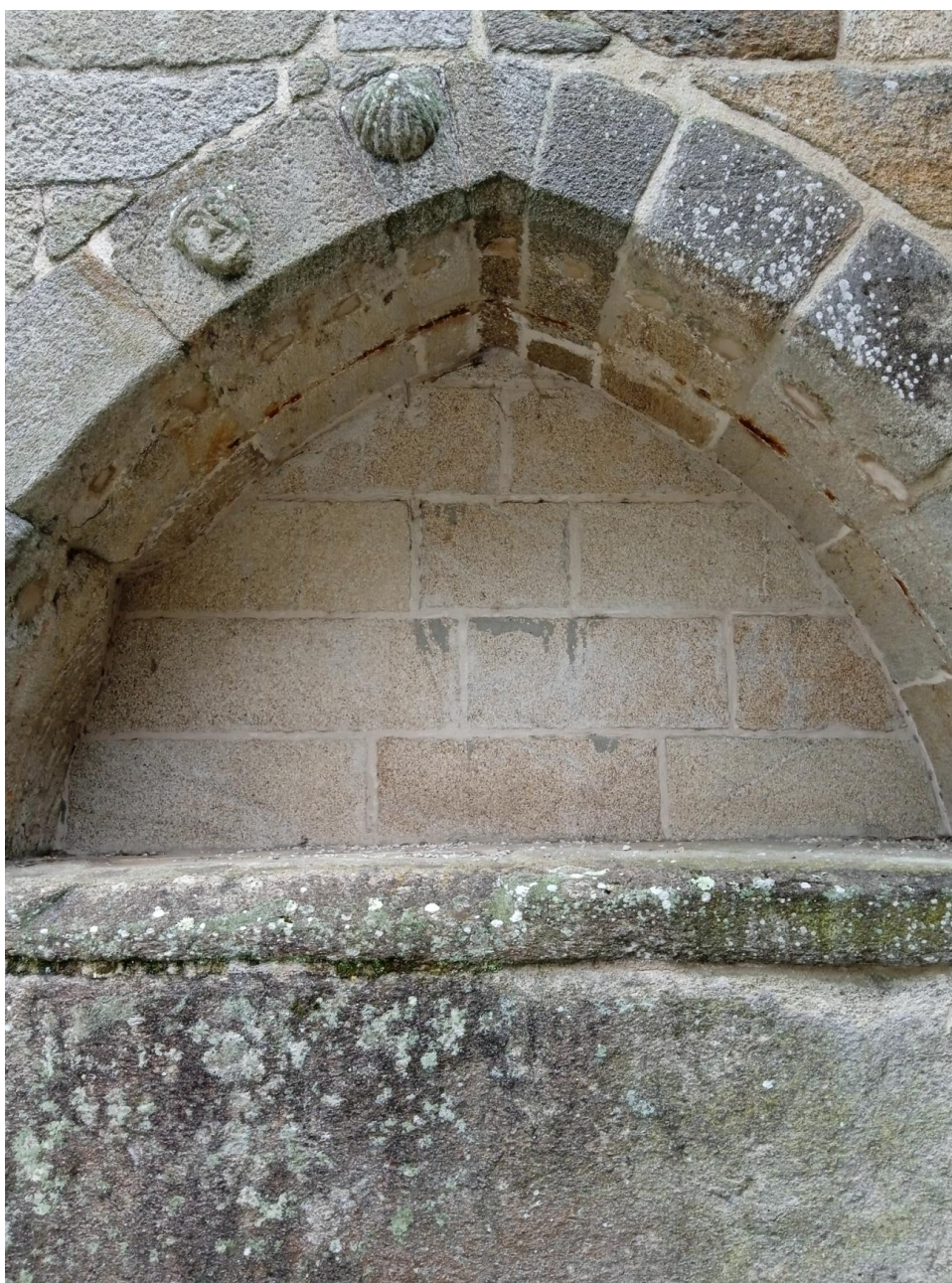
Arcosolio de la fachada principal de Sta. María A Nova con “vieira” esculpida en relieve
