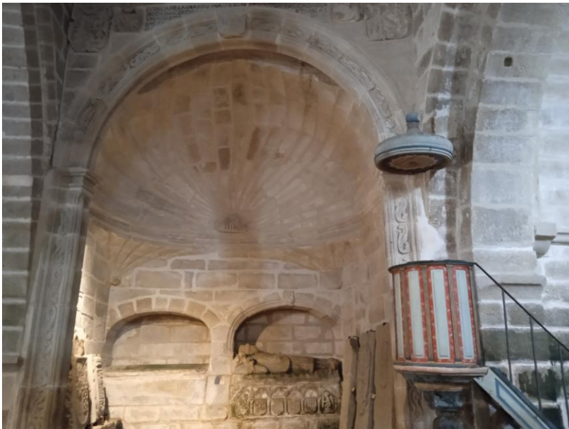
Capilla funeraria de los Carneiro (siglo XVI) con bóveda en forma de concha en Sta. María A Nova
